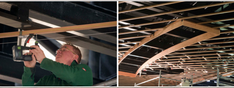
Referenzprofil für die erste Lage des Deckenscreens
