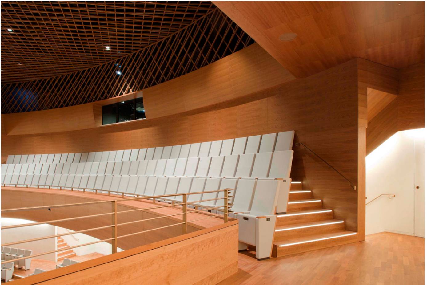
Einblick in ein Raumkunstwerk. Aufgesetzte Geländer passen die Brüstungshöhe unterschiedlichen Sicherheitsvorgaben an
