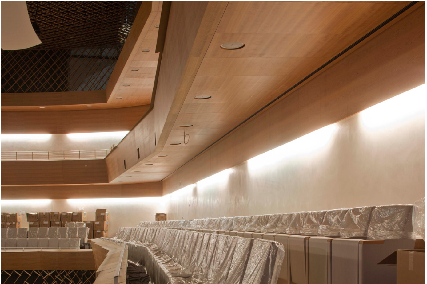
Hohe Schule des Furnierens: Horizontale Flächen zeigen einen Rapport aus Streifern, die vertikalen Flächen gestürzte Blumen
